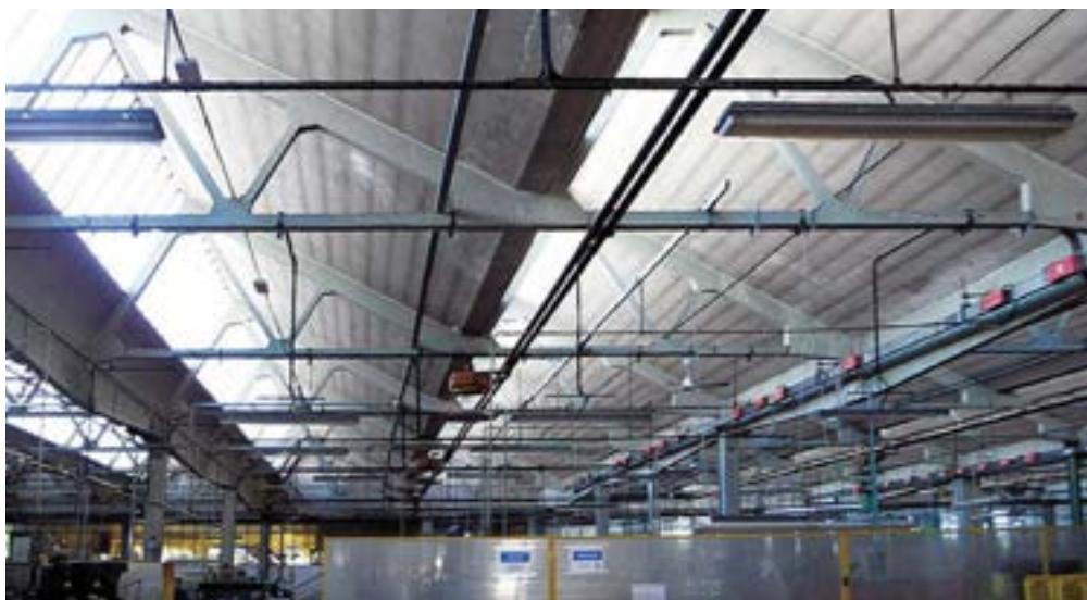
Figura 2 Travi di copertura a shed del Capannone 1.
