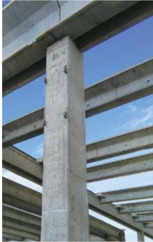
Figura 20 Edificio 2_Pilastro cerchiato per adeguamento sismico.
