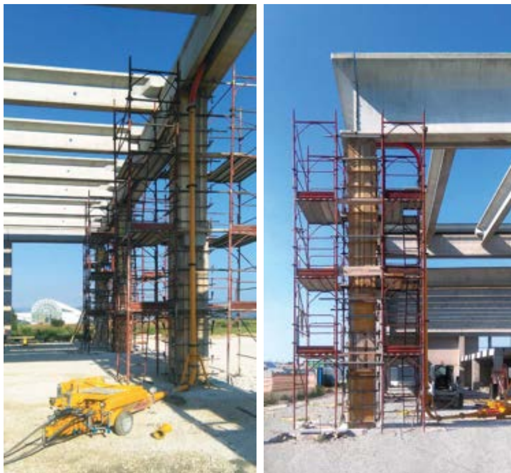
Figura 19 Edi cio 2_Armatura della cerchiatura su pilastri per adeguamento sismico.
