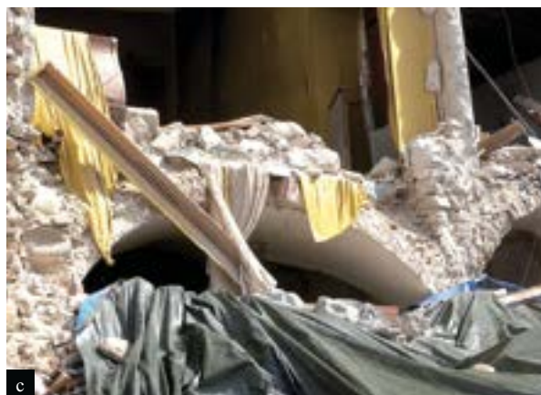
Figura 14 Solai lignei: travi appoggiate su paramento interno ad Amatrice (a) e travi appoggiate sull'intera sezione muraria ad Accumoli (b); volte in muratura al piano terra di alcuni edifici di Amatrice (c) (in basso).
