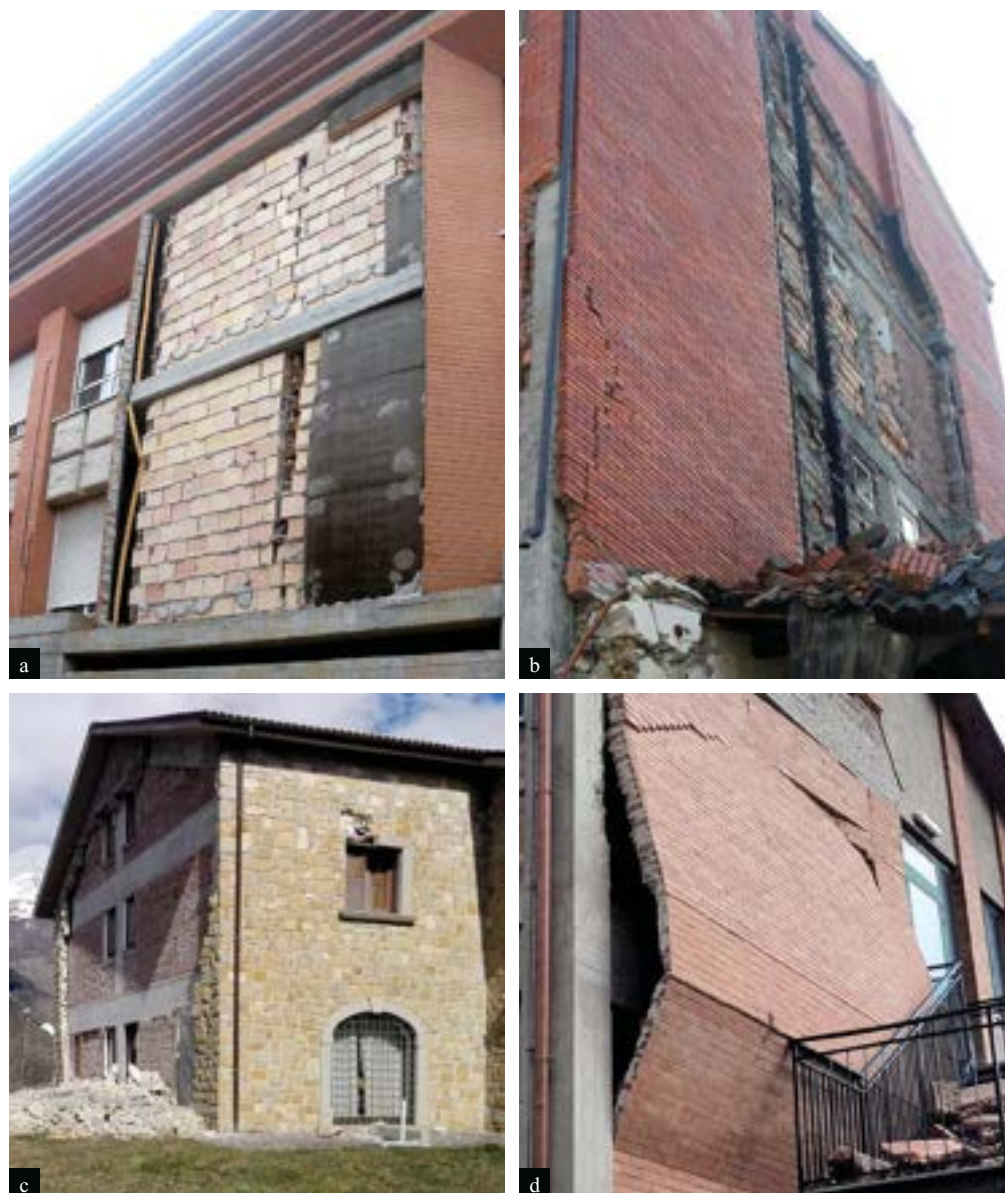
Figura 42 Esempi di espulsione fuori piano del paramento esterno ad Amandola (a), Amatrice (b) e c) e Norcia (d).
