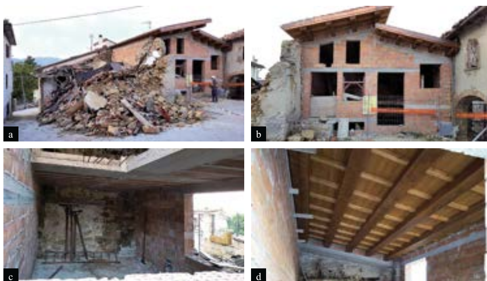
Figura 39 Edificio residenziale in muratura moderna in blocchi, inserito in aggregato strutturale a San Capone, frazione di Amatrice: visione di insieme (a) e (b), dettaglio della struttura muraria e del solaio intermedio (c) e dettaglio della copertura lignea e del cordolo sommitale in c.a. (d).
