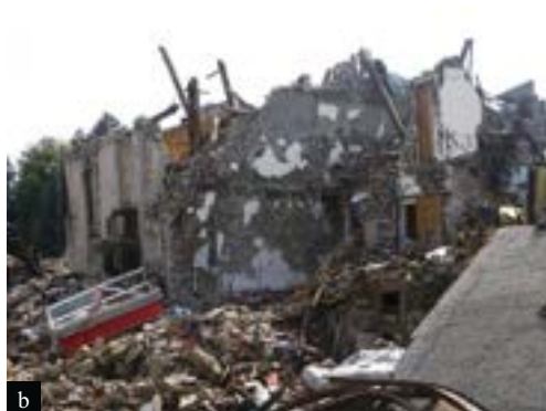
Figura 28 Esempi di collasso della copertura a Borgo Sant'Antonio, frazione di Visso, (a) ed Amatrice (b); danno per interazione tra la copertura e le pareti perimetrali a Castelsantangelo sul Nera (c).
