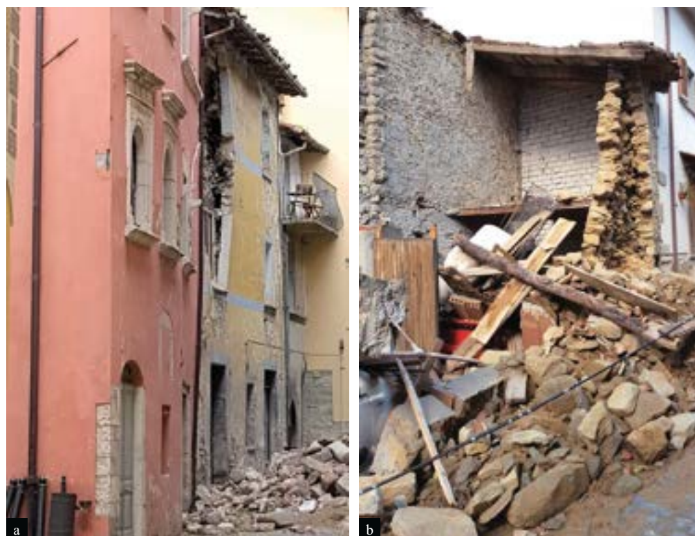
Figura 25 Instabilità fuori piano del paramento esterno di un edificio a Visso (a) e mancanza di connessione trasversale tra i paramenti di un edificio a Sant Angelo, frazione di Amatrice (b).
