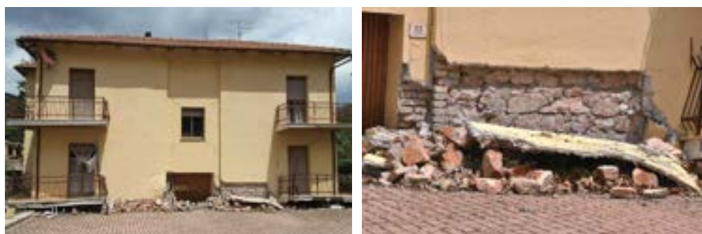
Figura 34 Collasso dell'edificio per la formazione di un piano debole al piano seminterrato (Norcia).
