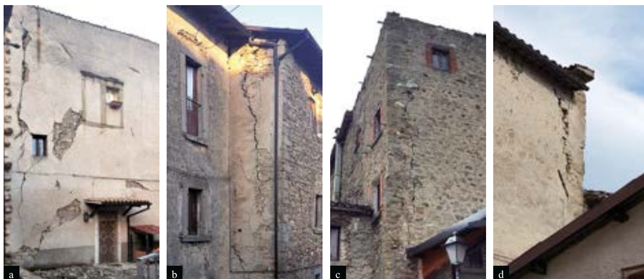
Figura 20 Distacchi della facciata ad Accumoli (a) e (b) e Vezzano, frazione di Arquata del Tronto, (c) e (d) (in alto).
