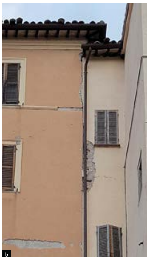
Figura 31 Interazione tra corpi di fabbrica adiacenti ad Illica, Accumoli (a) e Preci (b) (a sinistra).
