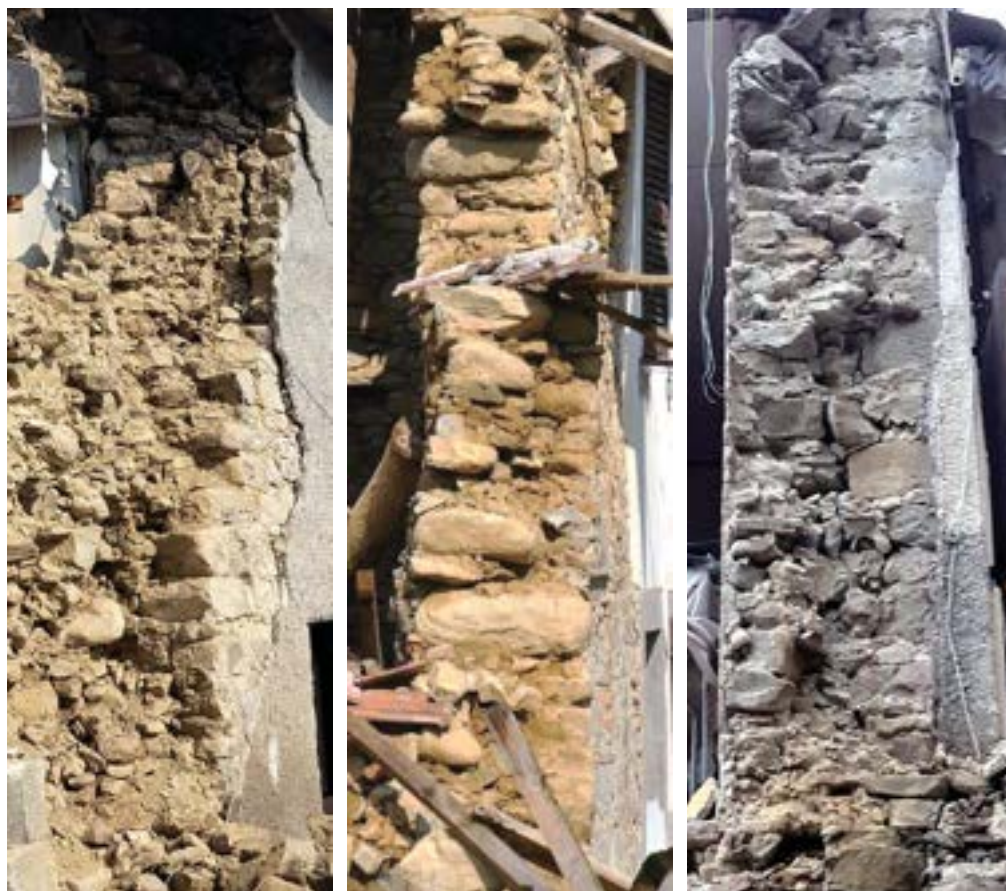
Figura 10 Sezioni trasversali di paramenti murari in pietra con tessitura irregolare e malta con leganti di scarsa qualità (Amatrice, frazione Sant'Angelo).
