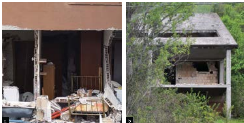
Figura 46 Esempi di danni alle tramezze di edifici localizzati ad Amatrice (a) e Castelsantangelo sul Nera (b).
