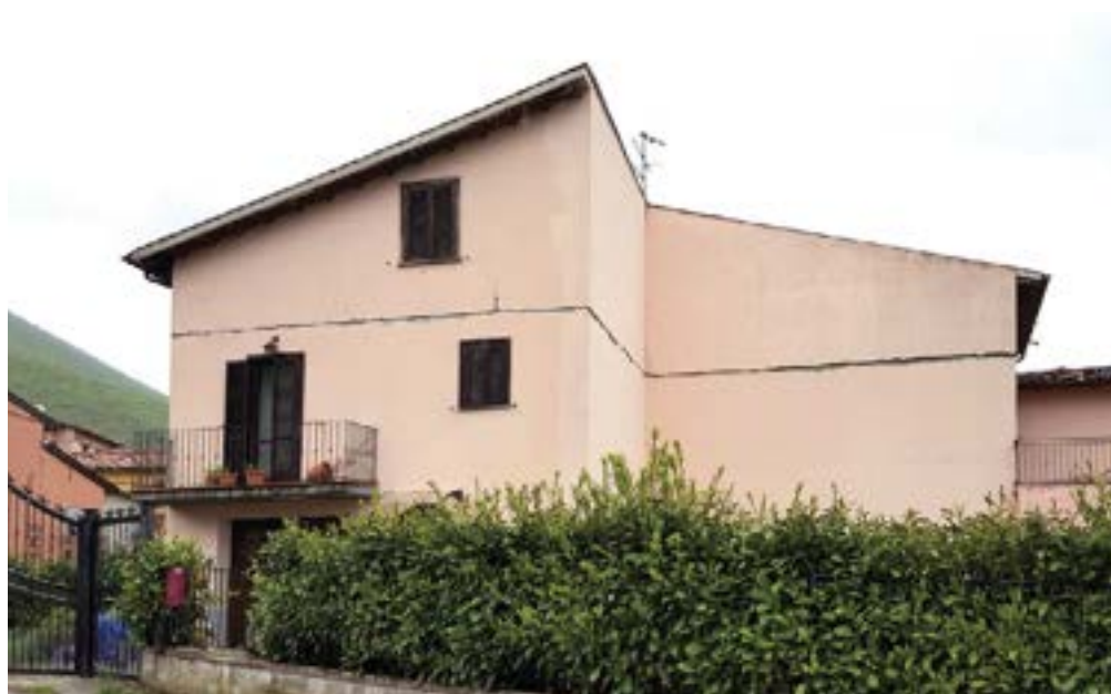
Figura 38 Edificio residenziale in muratura in mattoni a San Pellegrino, frazione di Norcia, oggetto di recente sopraelevazione in muratura in laterizio: lesione continua a livello dell'ultimo orizzontamento causata da probabile scorrimento del piano superiore in differente tecnologia rispetto alla porzione sottostante, più rigida.
