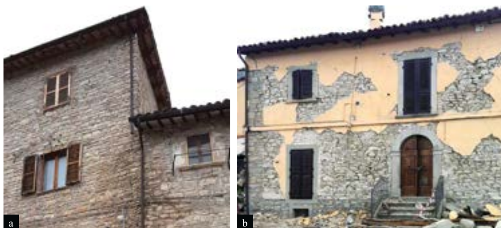
Figura 8 Esempi di viste frontali di paramenti murari in pietra con tessitura irregolare a Castelsantangelo sul Nera (a) e Amatrice, frazione Retrosi (b).
