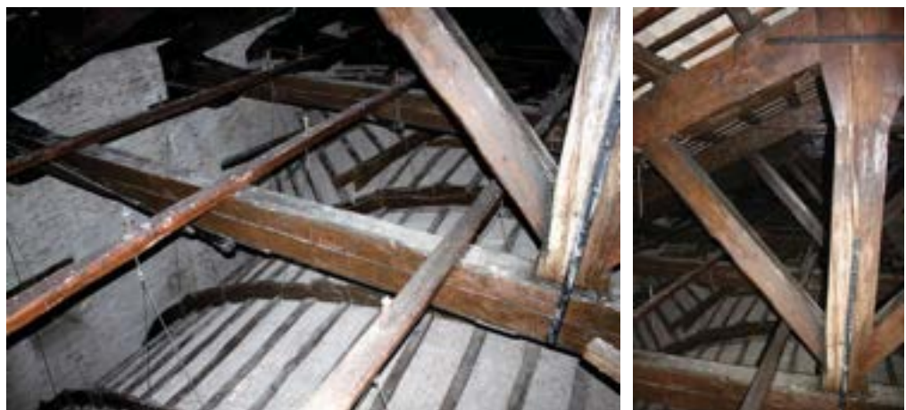
Figura 10 Esempio di volte in camorcanna.
