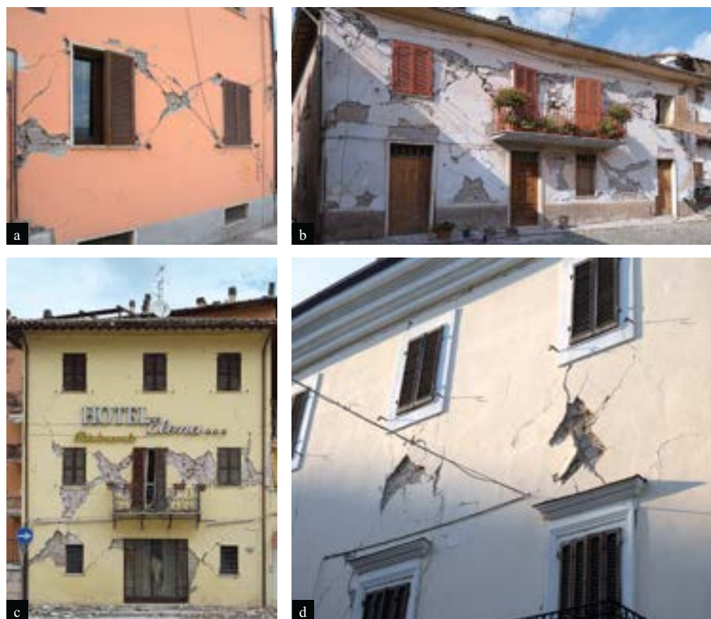
Figura 29 Meccanismi di danno nel piano ad Amatrice (a), Sant'Angelo di Amatrice (b), Visso (c) e Accumoli (d).
