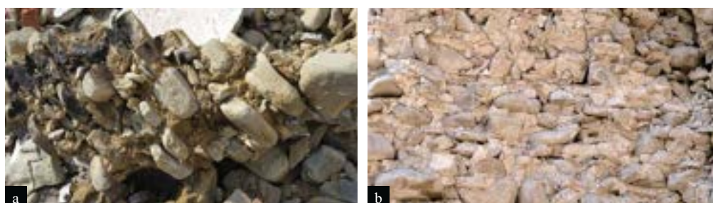
Figura 9 Sezione longitudinale di paramenti murari in pietra con tessitura irregolare ad Amatrice, frazione Sant'Angelo (a) e Amatrice (b).
