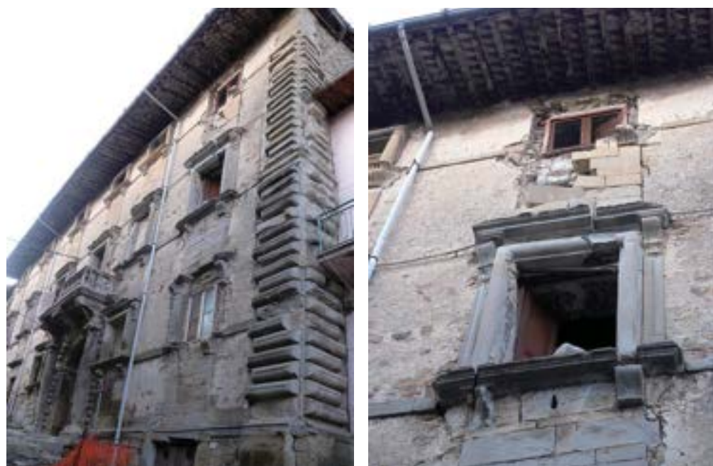
Figura 30 Distacco di cornici lapidee in corrispondenza delle aperture ad Accumoli.
