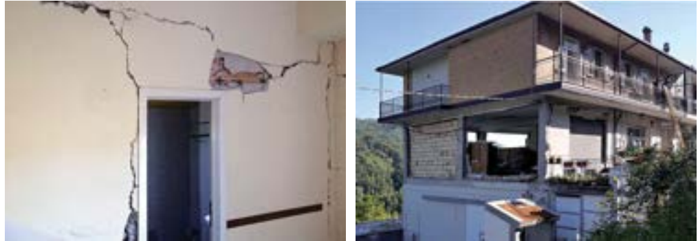
Figura 2 Tipici danni alle tamponature.
