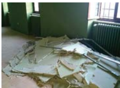
Figura 48 Esempio di collasso di una controsoffittatura in cartongesso a Sarnano.
