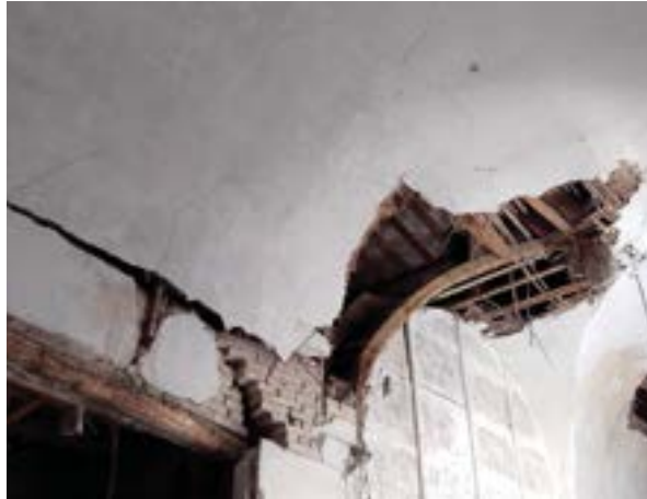
Figura 11 Tipici danni alle volte in camorcanna.
