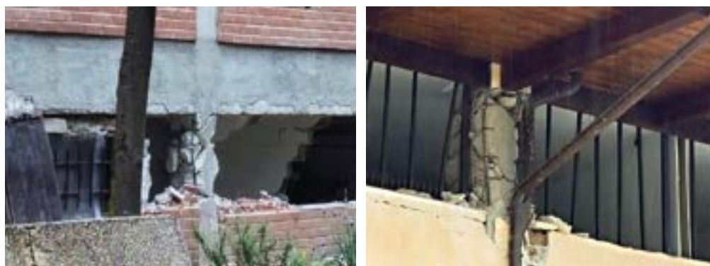
Figura 45 Esempi di danni riscontrati agli elementi in cemento armato di edifici di Norcia, dovuti all'interazione tra la tamponatura e la struttura.
