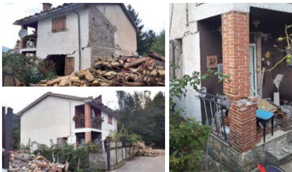
Figura 35 Edificio residenziale in muratura in mattoni di calcestruzzo in frazione Saletta, comune di Amatrice: lesioni causate da probabile scorrimento del piano superiore rispetto al piano terra.
