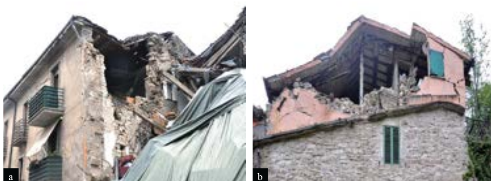
Figura 23 Meccanismi di ribaltamento fuori piano della sommità della facciata ad Amatrice (a), Castelsantangelo sul Nera (b), Visso (c) e (d) e Preci, Abbazia S. Eutizio (e) (a sinistra e in basso).
