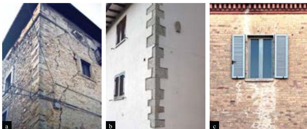
Figura 11 Presenza di pietre cantonali ad Accumoli (a) e Preci (b); Muratura in mattoni pieni a più teste (c).
