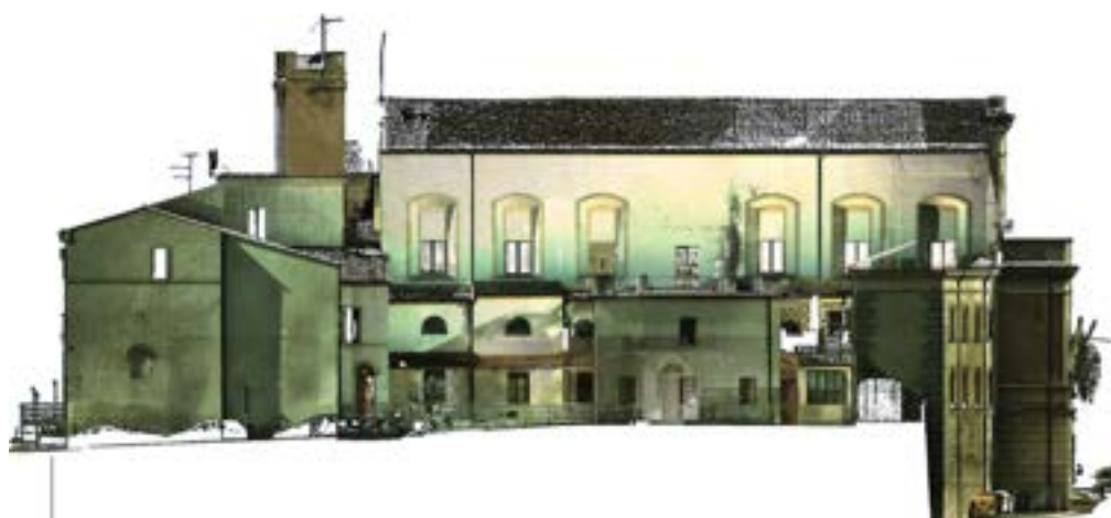
Figura 5 BIM e Beni culturali (Prof. Lenci et al., Università Politecnica delle Marche), dal Cloud Point al FEM. Convento di San Francesco ad Alto, Ancona.
