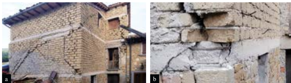
Figura 36 Edificio in muratura in mattoni di tufo sito a Saletta, frazione di Amatrice, con lesioni diagonali a taglio nei letti di malta con probabile incipiente attivazione di meccanismi locali di ribaltamento ed espulsione di cunei di muratura; dettaglio del cordolo di piano in c.a. (b).
