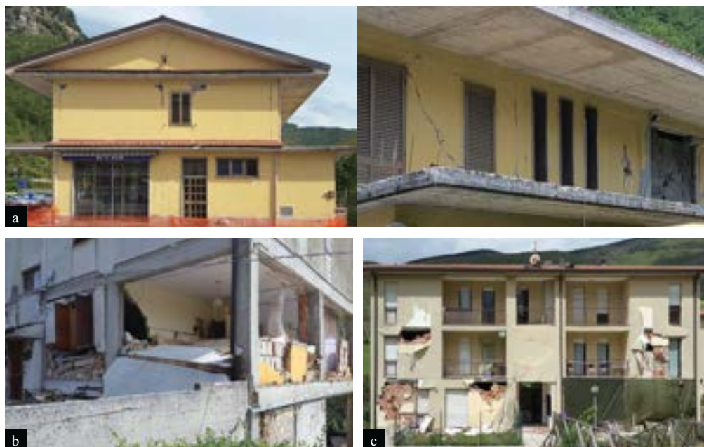
Figura 44 Esempi di danni riscontrati a tamponamenti a singolo paramento con danni nel piano e crolli fuori dal piano ad Arquata del Tronto (a) e Norcia (b) e (c).
