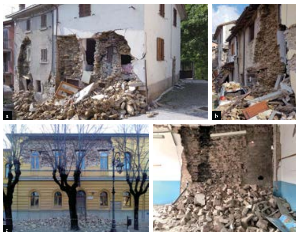
Figura 26 Crolli per insufficiente qualità della muratura a Sant Angelo, frazione di Amatrice, (a) e (b) e nella scuola elementare di Caldarola (c).
