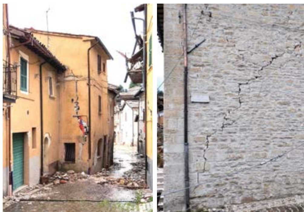
Figura 20 Distacchi della facciata ad Accumoli (a) e (b) e Vezzano, frazione di Arquata del Tronto, (c) e (d) (in alto).
