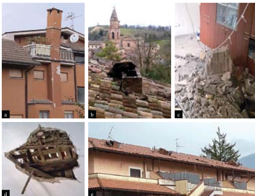
Figura 47 Esempi di danni e collassi di comignoli ad Amatrice (a), Caldarola (b), Cossignano (c e d), Norcia (e).
