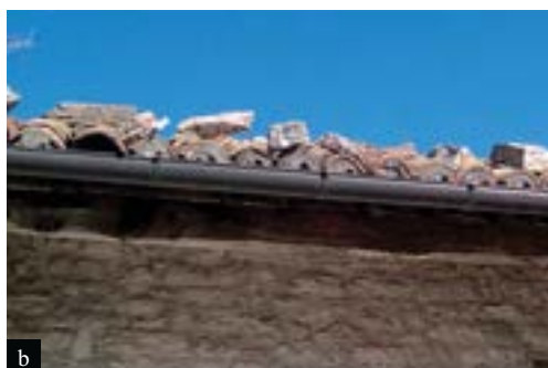
Figura 49 Esempi di danni rilevati in un manto di copertura di un edificio a Castesantangelo sul Nera (a) e presenza di fermacoppi in un edificio a Pieve Torina (b).
