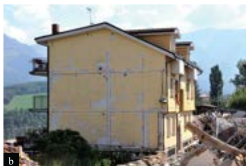
Figura 13 Edifici con telaio in c.a. con tamponature in blocchi in laterizio pluristrato a Camerino (a) ed edifici con telaio in c.a. con tamponature in blocchi di calcestruzzo aerato autoclavato monostrato (b), ad Amatrice (a sinistra).
