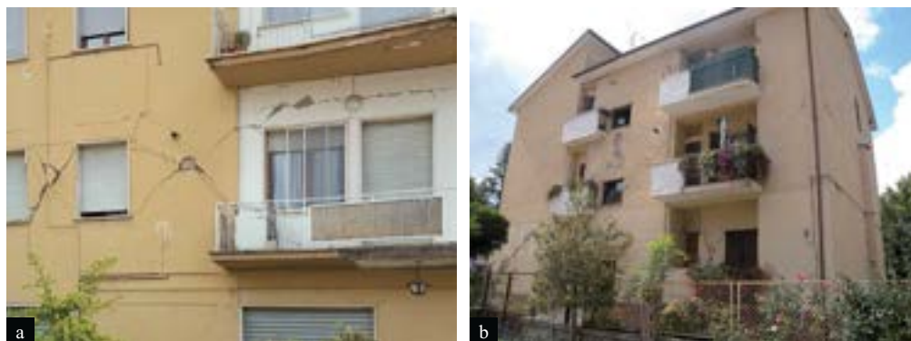
Figura 33 Danni fuori piano di edifici in pietra moderni a Norcia (a) ed Amatrice (b).
