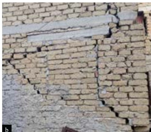
Figura 12 (a) Muratura in pietra listata (Illica); (b) Muratura in blocchi di tufo (Amatrice, frazione Saletta).
