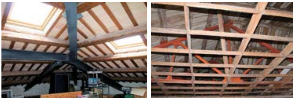
Figura 18 Uso di elementi metallici in copertura.
