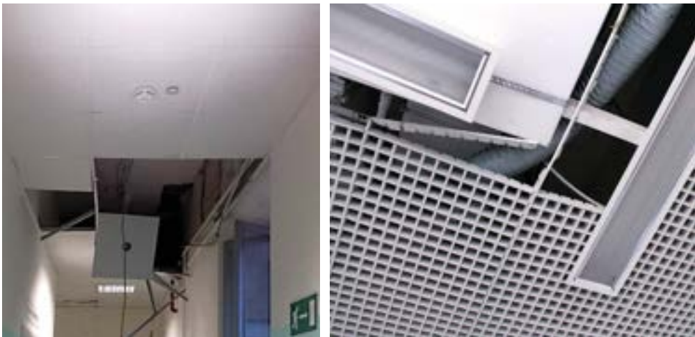
Figura 5 Tipico danneggiamento dei sistemi di controsoffittatura in edifici pubblici.
