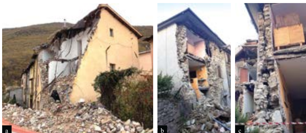
Figura 22 Ribaltamento fuori piano dell'intera facciata con coinvolgimento del muro ortogonale a Pieve, frazione di Ussita (a) e collasso fuori piano dell'intera facciata ad Accumoli (b) e (c).
